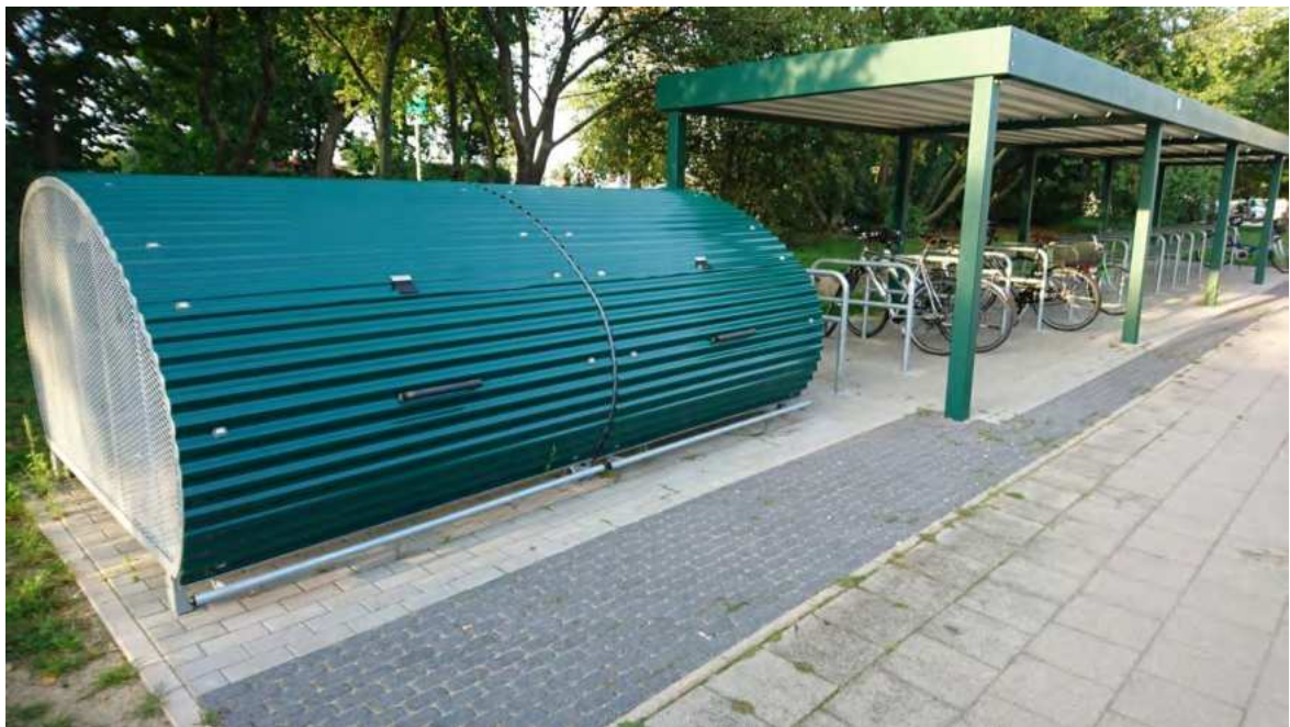
Abbildung 30: Abschließbare Fahrradgarage an der Haltestelle „Hohe Düne Fähre“
