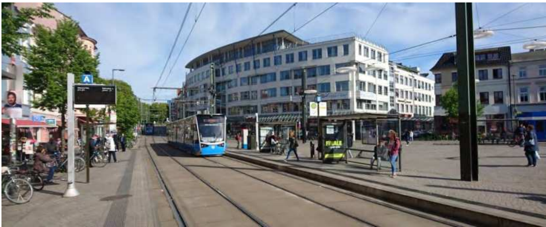
Abbildung 45: Der Doberaner Platz wurde im Jahr 2006 umfangreich umgebaut. (Umbau mit Verkehrsberuhigung des Platzes durch die Herausnahme des MIV sowie mit Modernisierung von vier Straßenbahnhaltestellen und einer Bushaltestelle)
